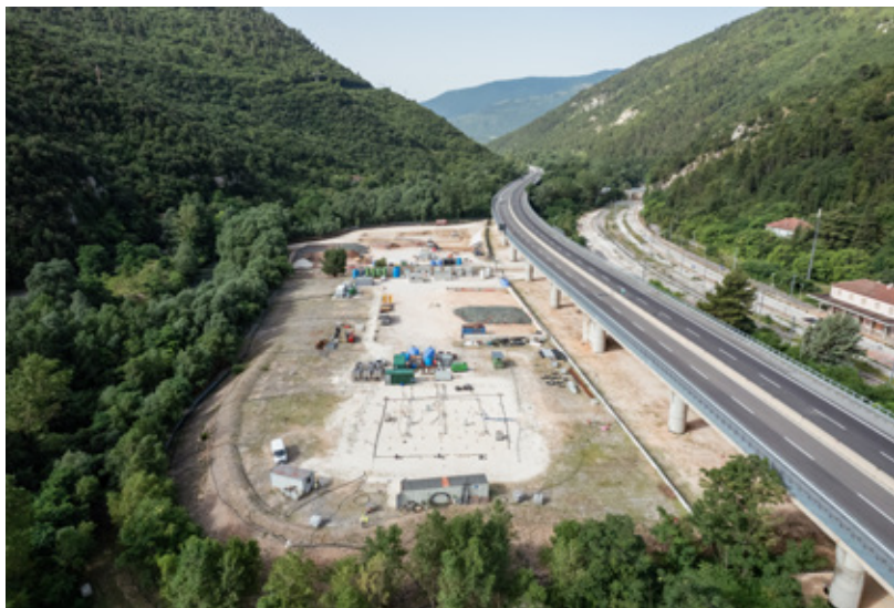
Herambiente (Tremonti) - Intervento Bonifica - Bussi Pescara
