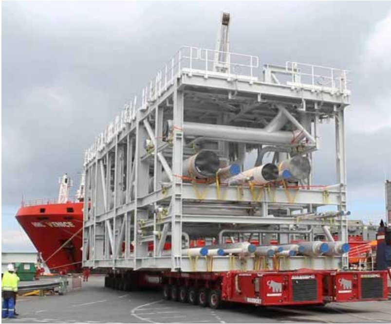
Fig. 1 - Esempio di modulo PAR (Pipe Rack Module)
