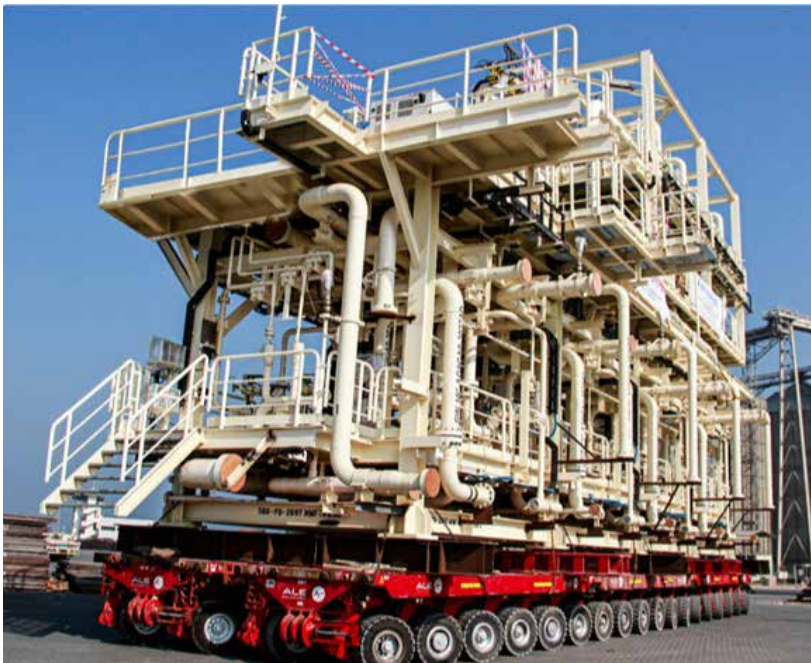
Fig. 2 - Esempio di modulo PAU (Process Assembly Unit)
