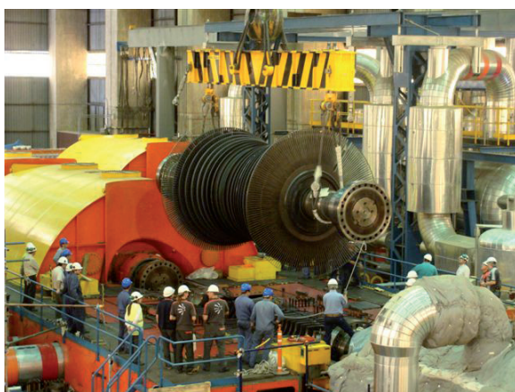
Fig. 2 - Sostituzione di uno dei tre stadi di bassa pressione della turbina
