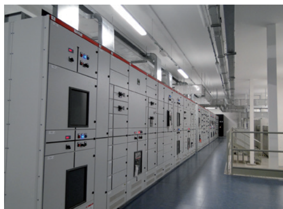
Distribuzione elettrica in media e bassa tensione per i data center di Telecomitalia a Rozzano, alle porte di Milano
