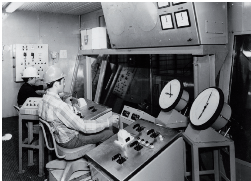
Impianto a Pul-Cimbot, Perù
