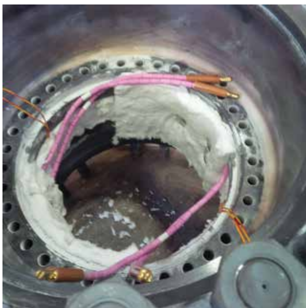
Fig. 6 - Trattamento termico localizzato sui due speroni del corpo pompa
