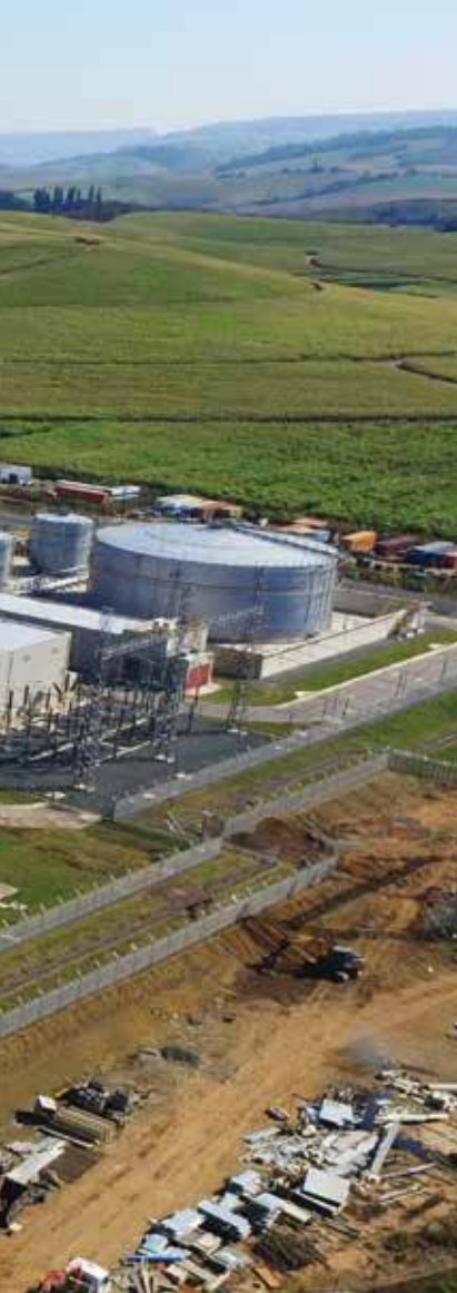
Panoramica aerea della centrale a ciclo aperto Avon in Sud Africa, completata nel luglio scorso dal consorzio Ansaldo Energia e Fata
