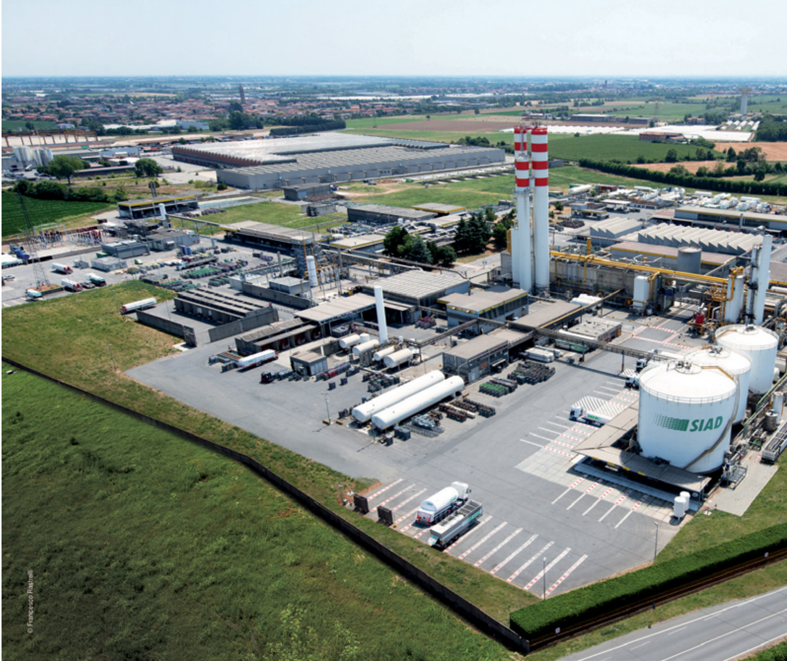
SIAD Factory in Osio Sopra (Bergamo), Italy
