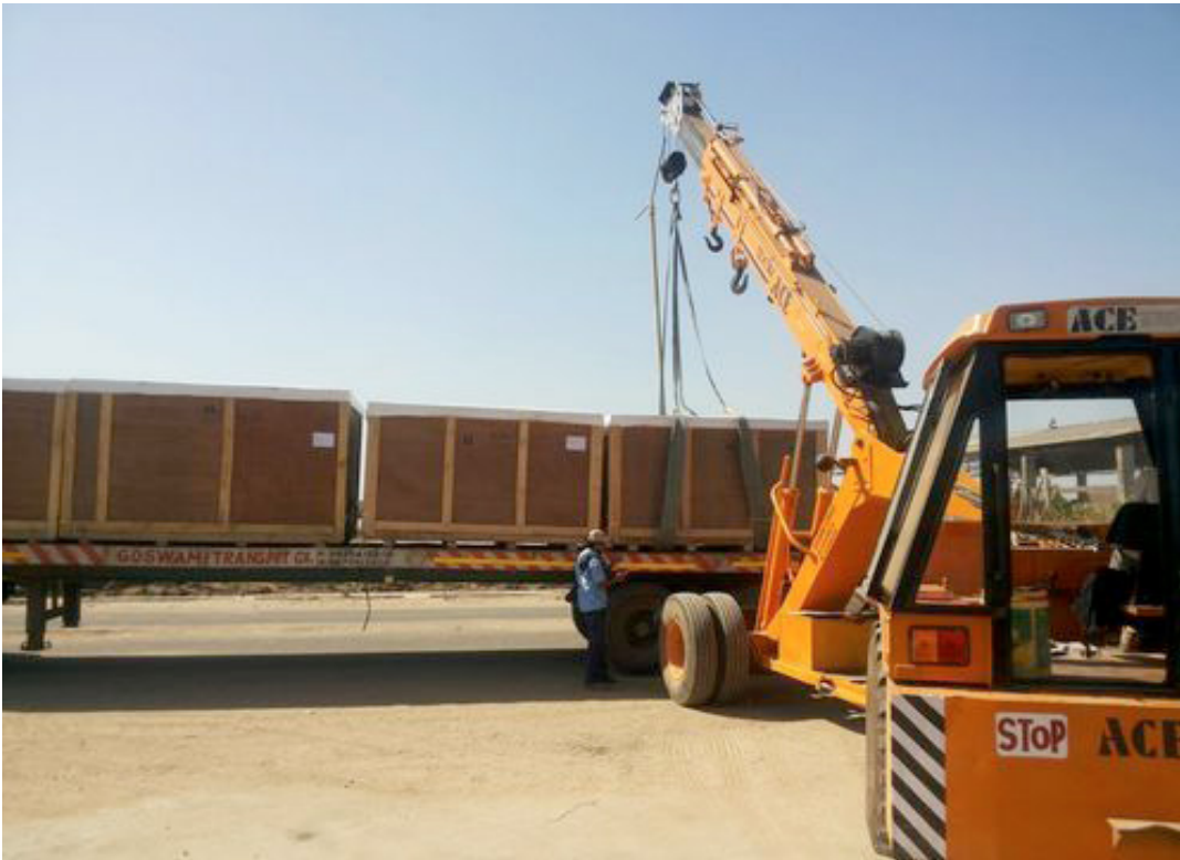
Fig. 8 - Carico materiale antincendio su bilico
