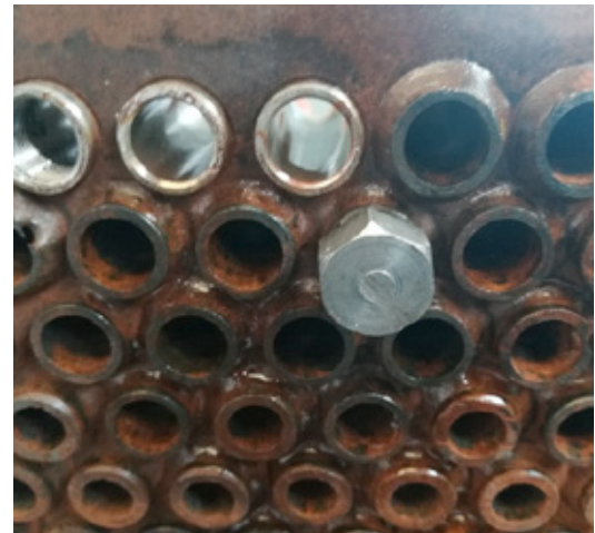
Figura 9 - Installazione tappo STP conico
